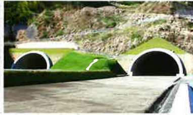
第二東名清水第四トンネル【静岡県】
