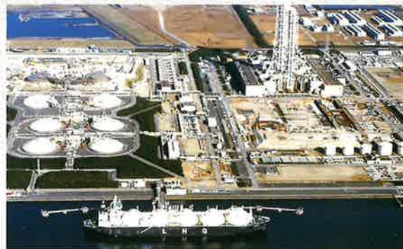
富津火力発電所 [東京電力(株)/千葉県]
